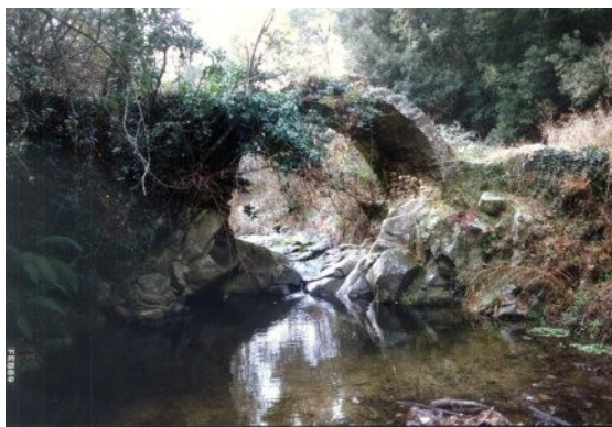
Figura 6-ponte ad arco sul fosso dell'Inferno nei pressi di Montorgiali
